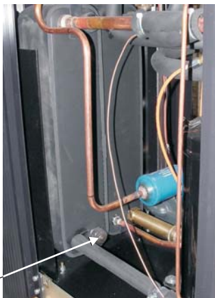
Fig. 4: Manicotto ad immersione per la sonda
