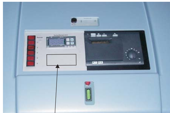
Fig. 2: Tagliare la pellicola in questo punto, inserire il termostato dal davanti
