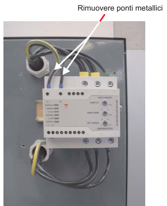
Figura 3: limitatore di corrente - versione precedente rimuovere i ponti metallici
