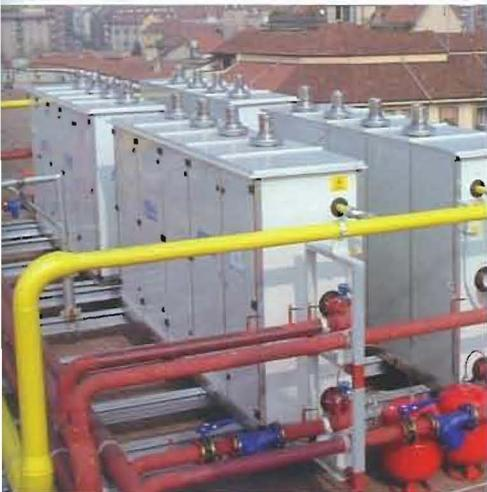
10 Caldaia modulare a condensazione installata in copertura.
