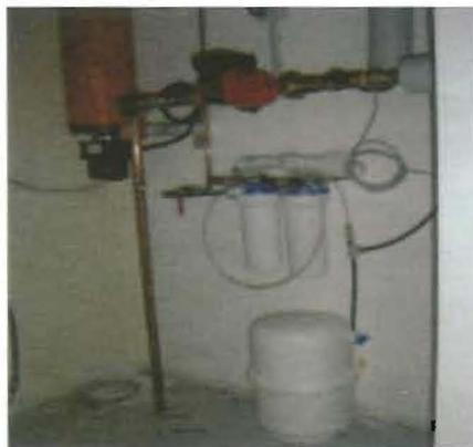
5 Umidificatore diretto ad ultrasuoni montato sul canale d'aria con l'osmosizzatore ed il suo serbatoio di riserva.
