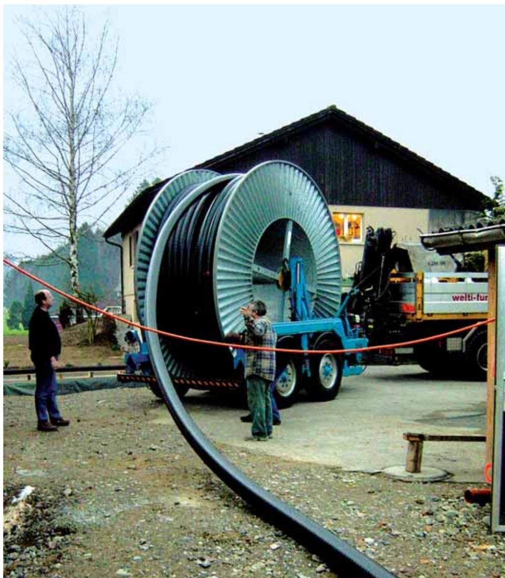
*I tubi precoibentati di tipo flessibile utilizzati nella distribuzione capillare del calore permettono di scavalcare e aggirare ostacoli anche imprevisti; il tubo di servizio può essere realizzato in polietilene reticolato, in rame (a spirale e liscio) o in acciaio inox (a spirale) secondo le esigenze di installazione. (Foto Brugg)*
