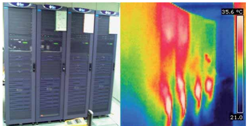
Diagnosi termica di cabine contenenti apparecchiature informatiche
