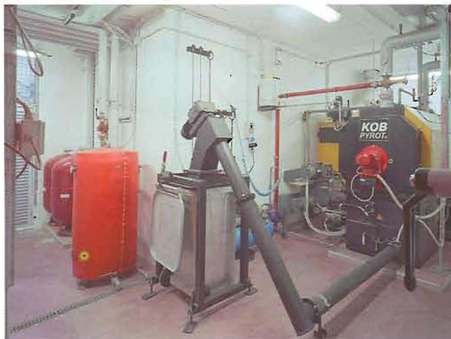
Il calore è prodotto da una caldaia a pellet con rendimento superiore al 90% sul PCI: il fornitore del combustibile certifica l'assenza di formaldeidi e di altri inquinanti dal pellet.
